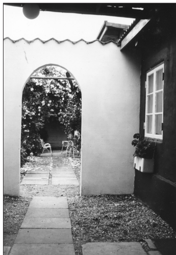
10.55 - En detalje i ombygningen af "Svenskehuset". - tb
