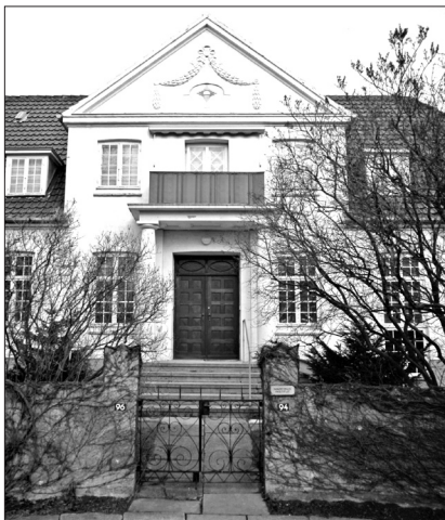
10.150 - Husets facade med Martinus altan. - et
